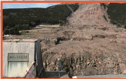
崩落した阿蘇大橋①
