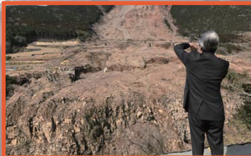
崩落した阿蘇大橋②
